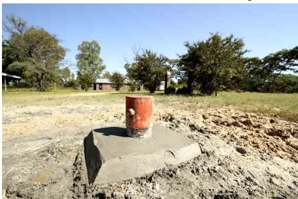
Den nye drikkevandsboring på skolen var netop færdig
