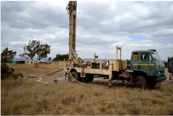
Bore-riggen starter på drikkevandsboringen Børnehjemmet ses i baggrunden
