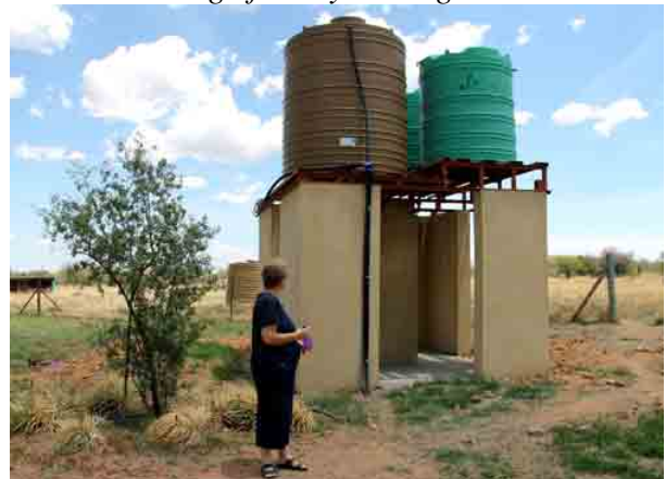
Vi ser de nye vandtanke på det nye stillads
