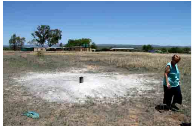
Boringen er færdig, og nu afventer man testpumpninger, efter at lagene igen har sat sig efter trykboringen
