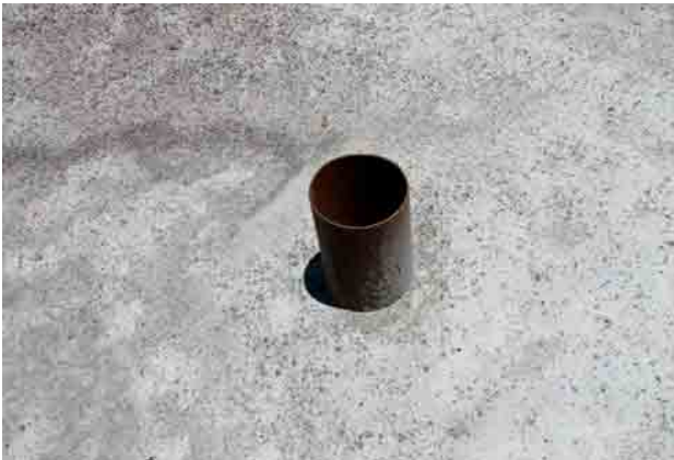
Nærbillede af boringen. Den er 100 meter dyb.
