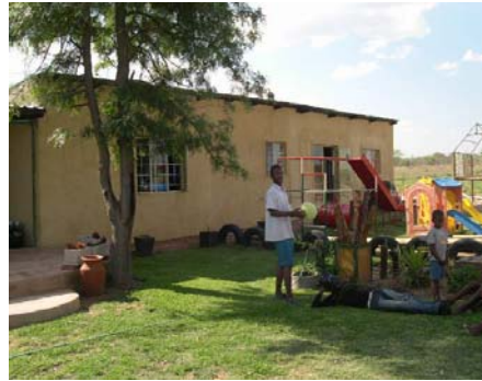
De 2 garager –nu ombygget til børnehjem
