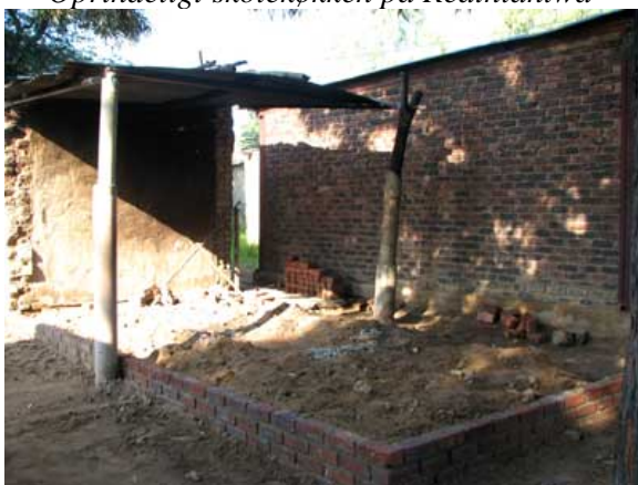
Skolekøkken under opbygning
