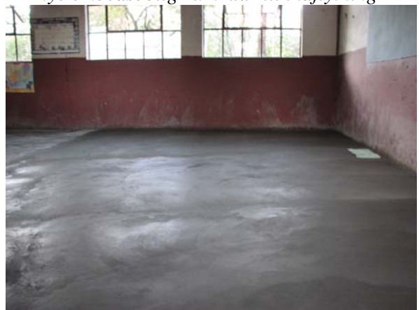
Og sådan ser gulvet ud efter at det er blevet repareret
