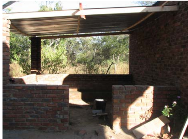
Nu bygges der et nyt skolekøkken med tag og bænke -og det kan tages i brug før regntiden
