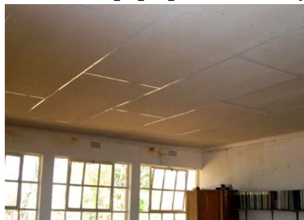
Loftet i klasseværelset efter reparationen
